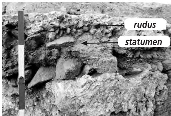
Detalle de la composición del suelo de opus signinum .
